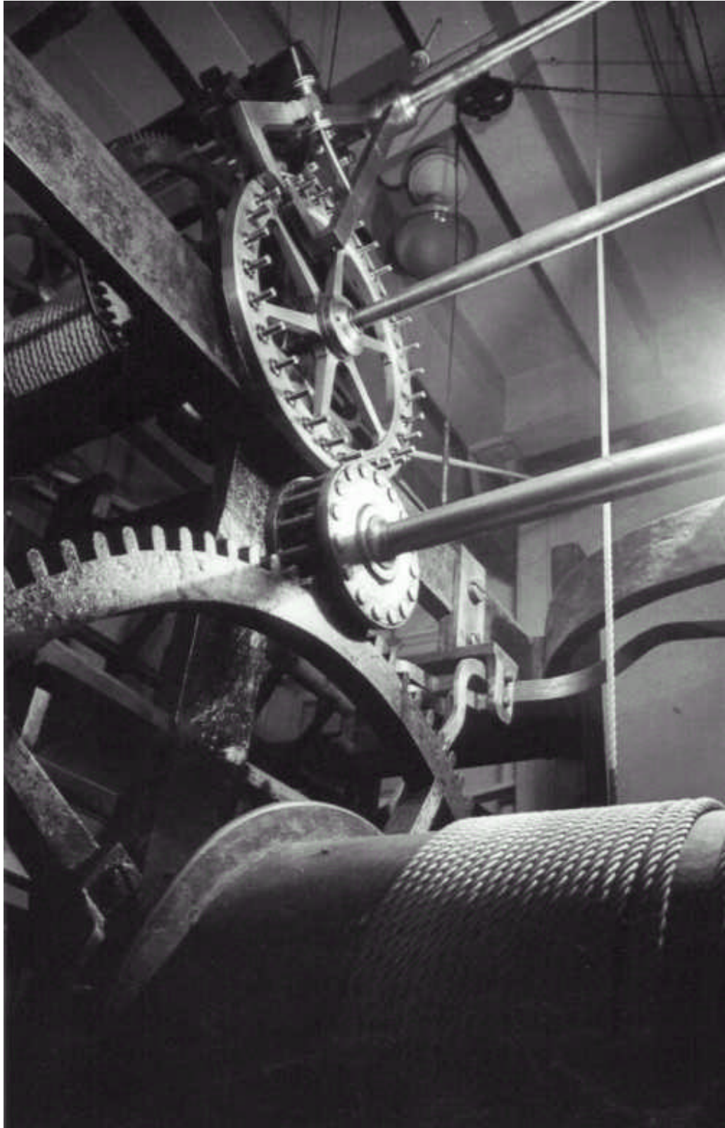
I ruotismi del sistema del Tempo quali rimasero fino allo smontaggio, ovvero con lo scappamento del De Lucia (1858)
